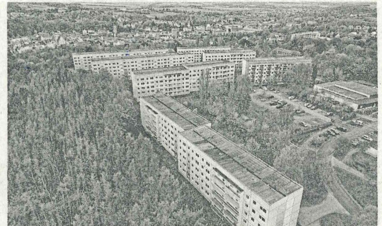
Das Plattenbaugebiet Kranzberg wird in den kommenden Jahren sein Erscheinungsbild verändern. 365 Wohnungen verschwinden.
